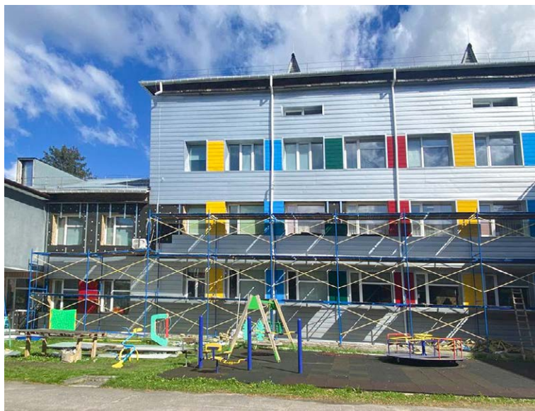
Фото 6. Комбінація систем НВФ «Профіль СМАРТ-15» та «Панель-СТАЙЛ» на фасаді Броварського ліцею №3.
